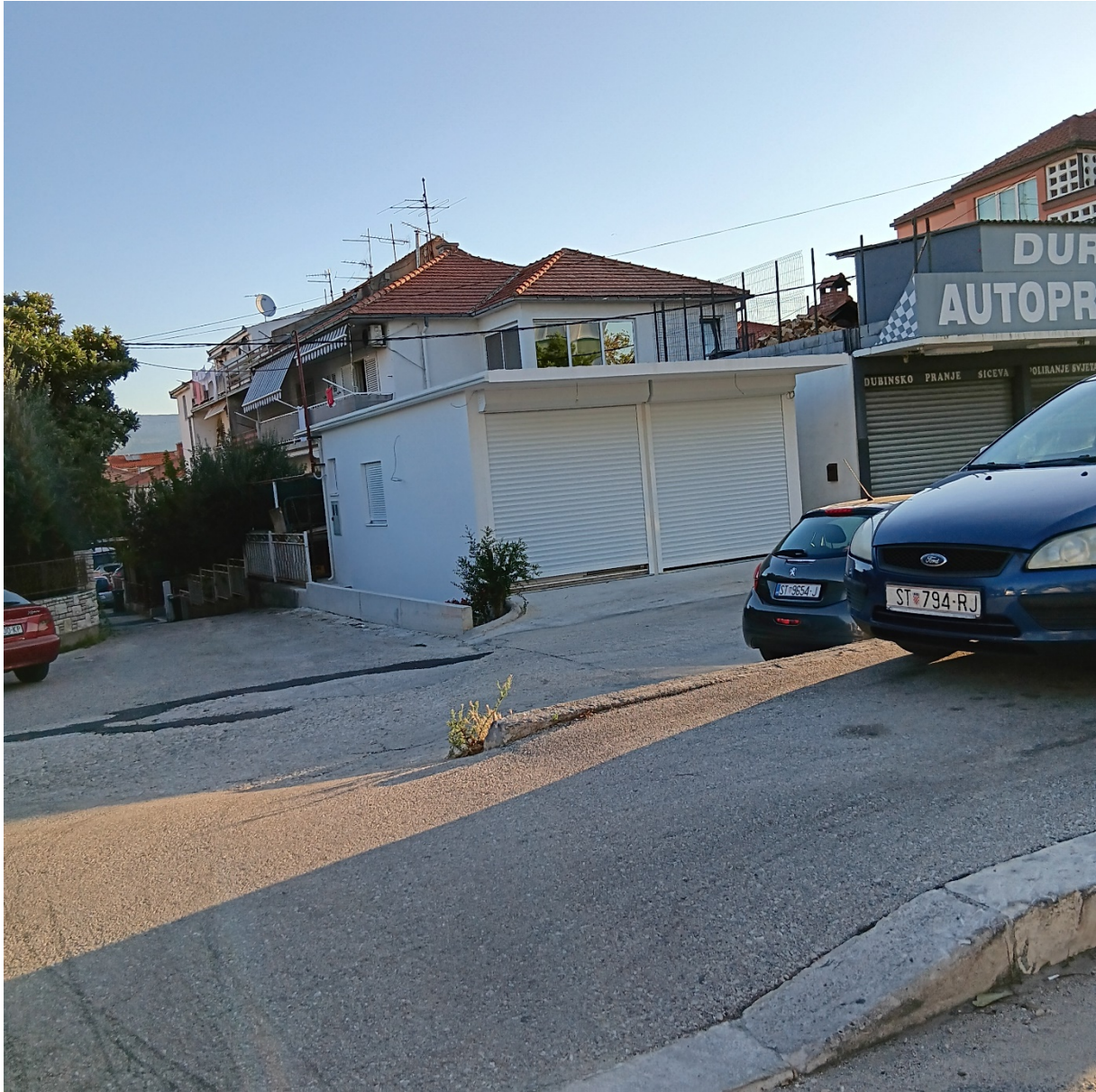
Foto 16 – Betonska građevina – Hercegovačka 119
