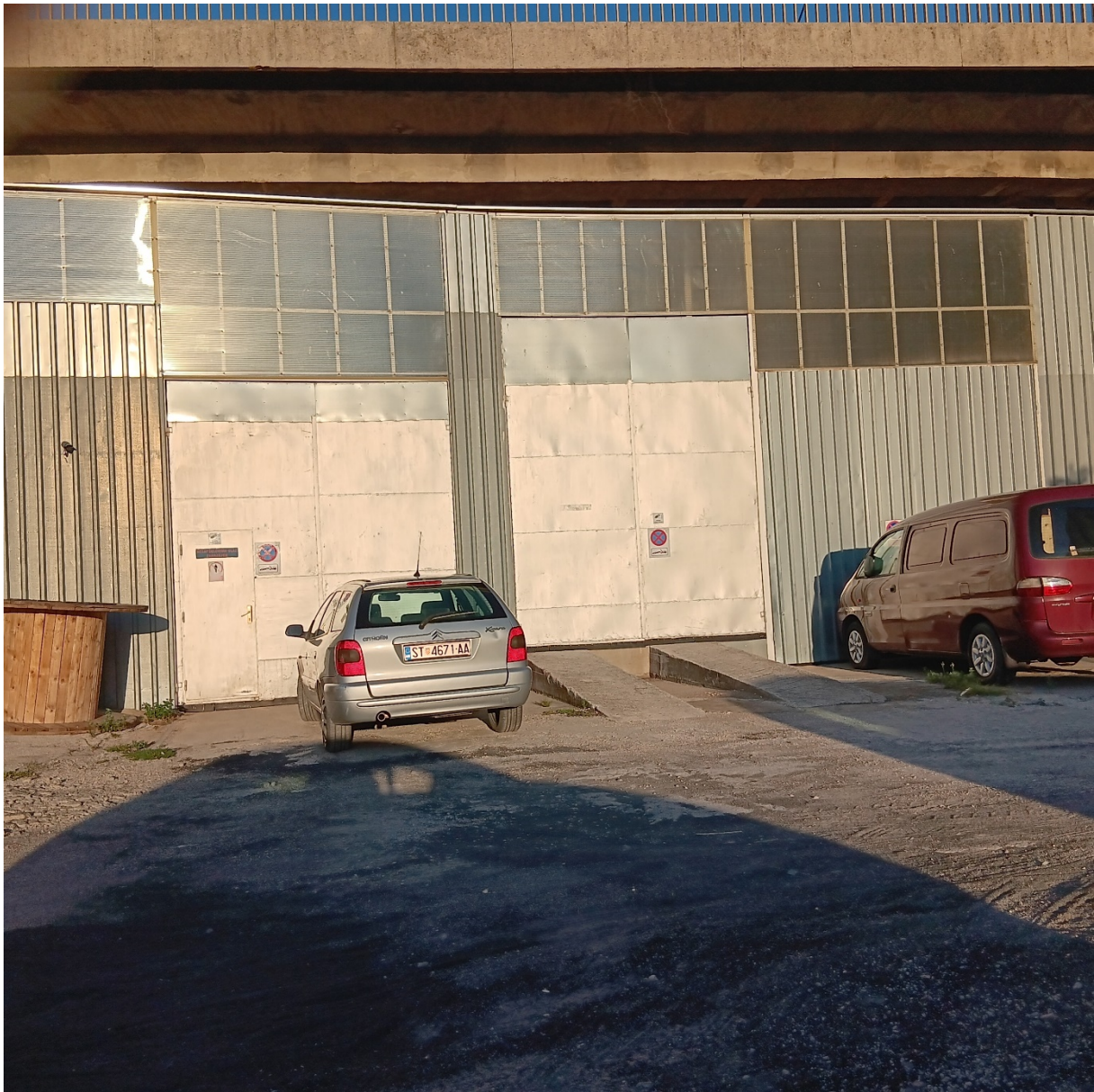
Foto 20 – Metalna konstrukcija – Stinice 1b
