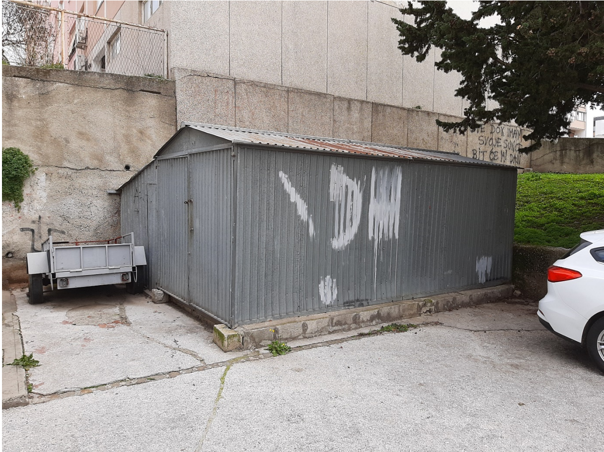
Foto 33 – Metalni objekt – Iločka 15
